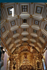
Nossa Senhora do Bom Despacho church
