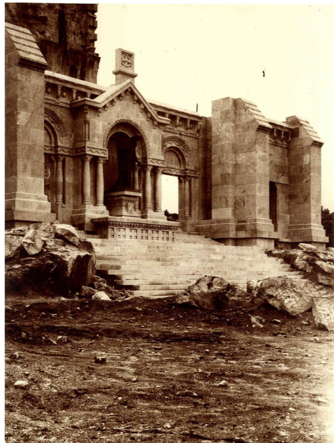
Pormenor da Construção do Templo de Santa Luzia – 1930 (Arquivo Municipal de Viana do Castelo)
