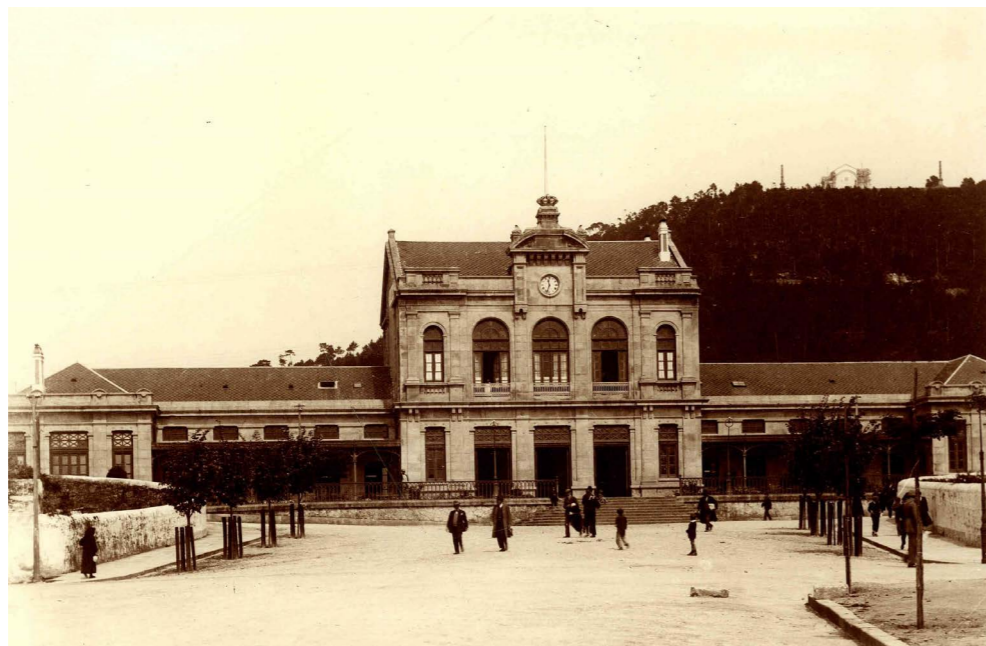
Estação de Caminhos de Ferro – 1930/1940 (Arquivo Municipal de Viana do Castelo)
