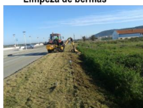
Limpeza de bermas
