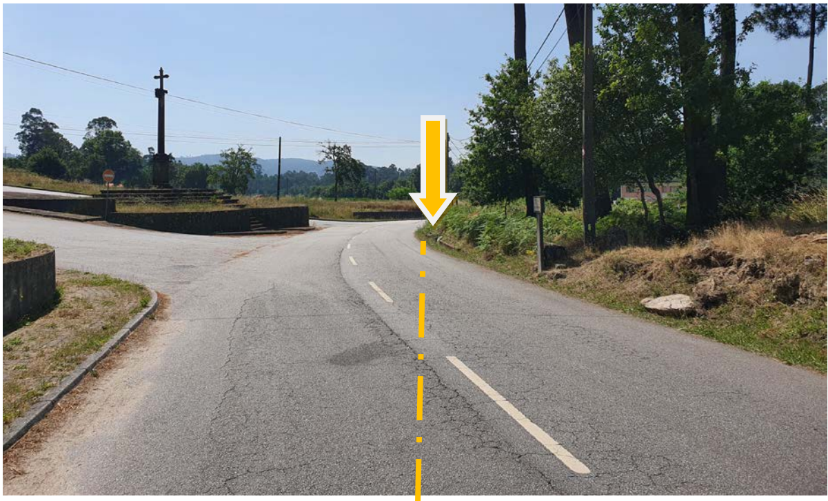
A conduta foi realizada para outra linha de água existente, em vala a céu aberto, que passa por baixo do cruzeiro
