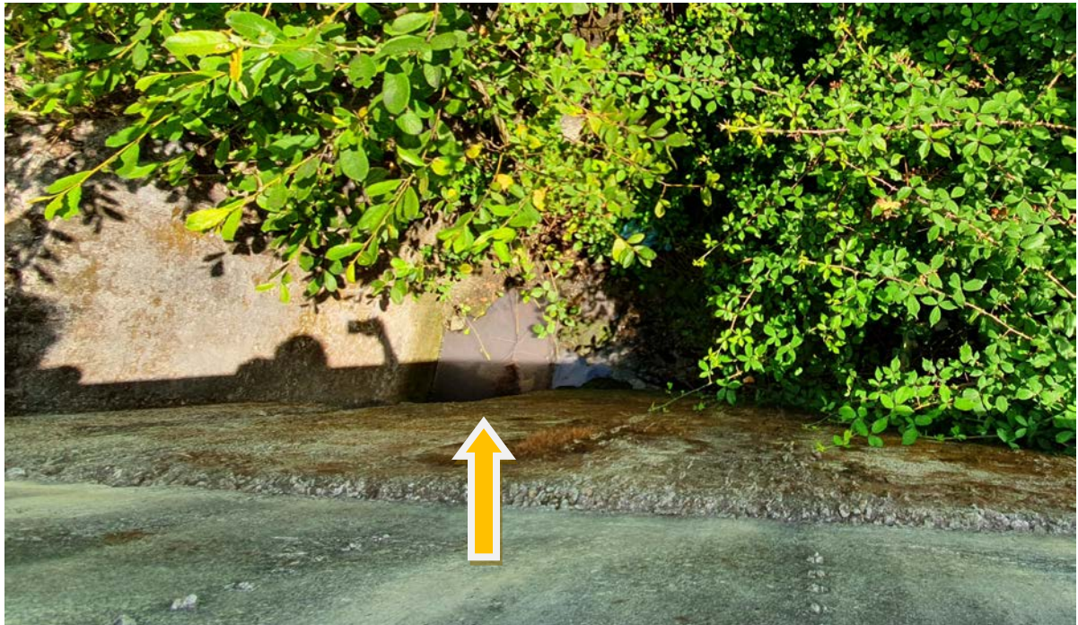
Linha de água visível a céu aberto que passa por conduta inferior à EN308
