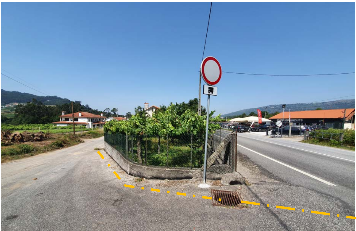
Continuidade da linha de água encaminhada
