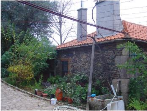
EDIFÍCIO PRINCIPAL - DEZEMBRO/2015
