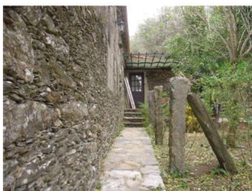
EDIFÍCIO PRINCIPAL - DEZEMBRO/2015
