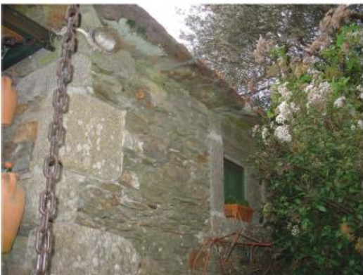
EDIFÍCIO PRINCIPAL - DEZEMBRO/2015
