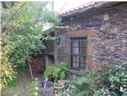
EDIFÍCIO PRINCIPAL - DEZEMBRO/2015
