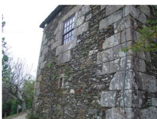
EDIFÍCIO PRINCIPAL - DEZEMBRO/2015
