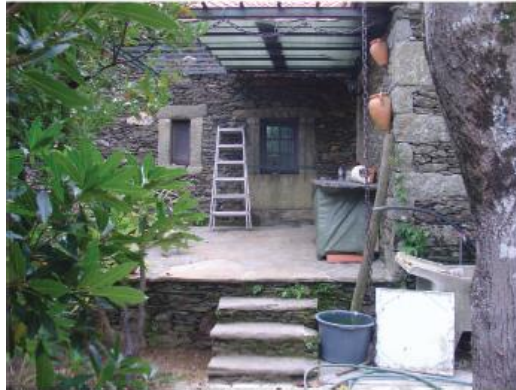
EDIFÍCIO PRINCIPAL - DEZEMBRO/2015
