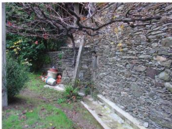
EDIFÍCIO PRINCIPAL - DEZEMBRO/2015
