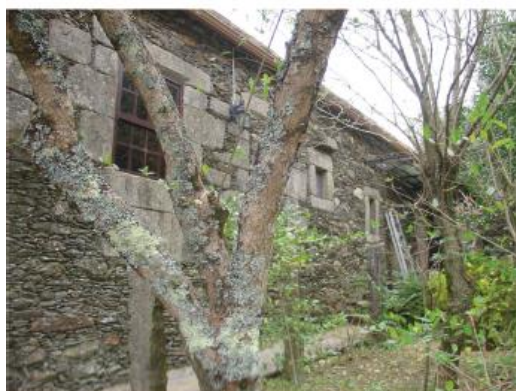
EDIFÍCIO PRINCIPAL - DEZEMBRO/2015
