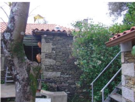
EDIFÍCIO PRINCIPAL - DEZEMBRO/2015
