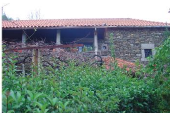
EDIFÍCIO PRINCIPAL - DEZEMBRO/2015
