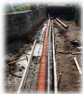
Figura n.º 3 e n.º 4 – Execução de estação elevatória e instalação do coletor de saneamento
