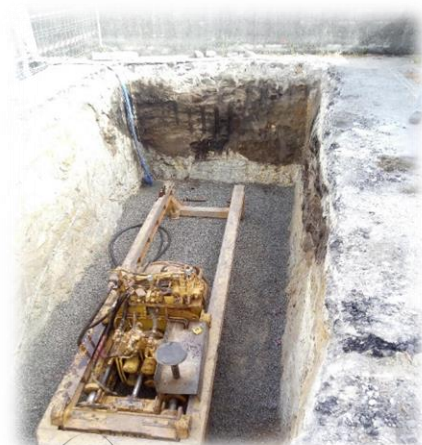
Figura n.º 5 e n.º 6 – Perfuração horizontal para atravessamento ferroviário da linha do Minho para instalação do coletor de saneamento
