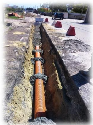
Figura n.º 1 e n.º 2 – Instalação do coletor de saneamento
