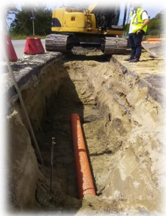
Figura n.º 1 e n.º 2 – Instalação do coletor de saneamento
