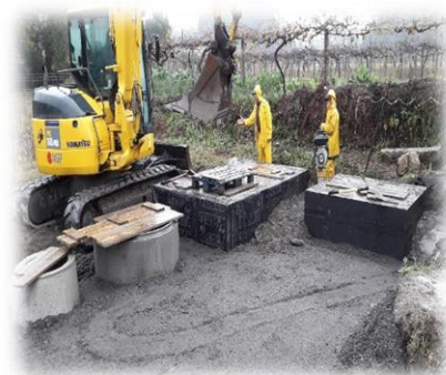
Figura n.º 3 e n.º 4 – Execução de estação elevatória e instalação do coletor de saneamento
