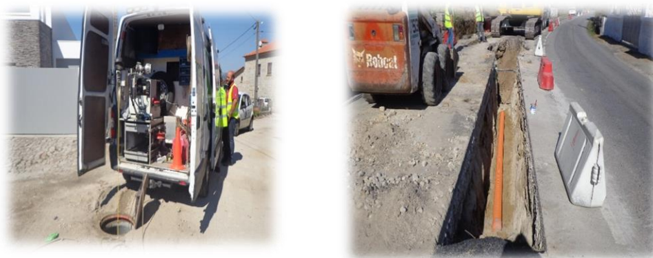
Figura n.º 9 – Inspeção vídeo ao coletor
