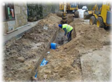
Instalação da conduta de água
