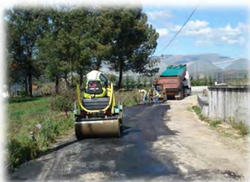
Trabalhos de pavimentação betuminoso
