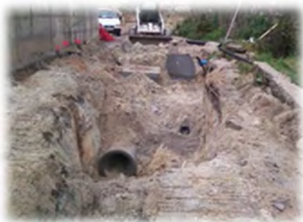
Instalação do coletor pluvial
