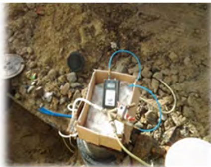
Ensaio de estanquidade à rede residual
