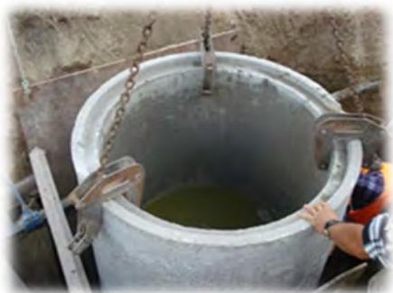
Execução de caixa de visita
