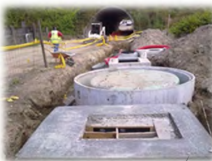
Execução de estação elevatória
