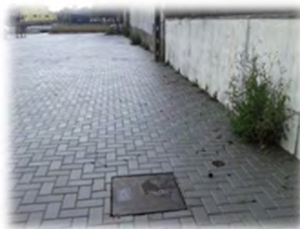
Ramal de água e águas residuais
