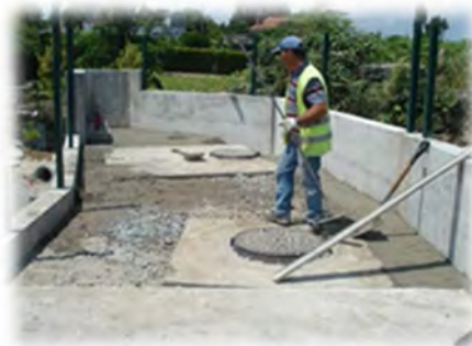
Acabamentos na estação elevatória
