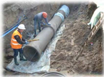
Instalação de coletor pluvial
