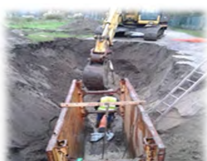
Instalação de coletor de águas residuais
