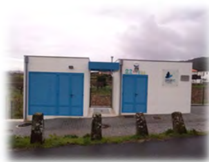
Estação elevatória de águas residuais
