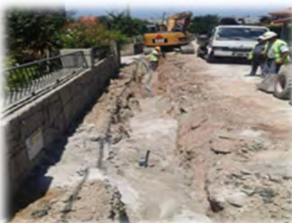
Instalação da conduta de água Couto
