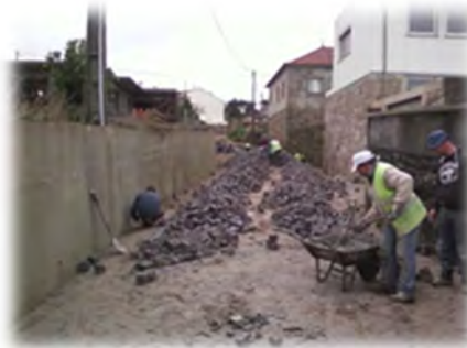
Trabalhos de pavimentação em cubo
