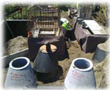
Execução da estação elevatória
