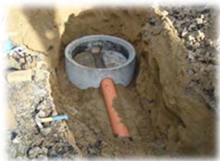
Execução de caixa de visita
