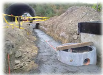
Instalação de rede de saneamento
