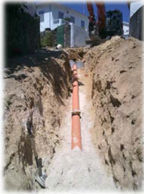
Instalação de rede de saneamento
