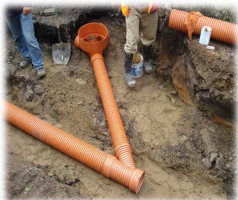
Instalação de ramal de águas residuais
