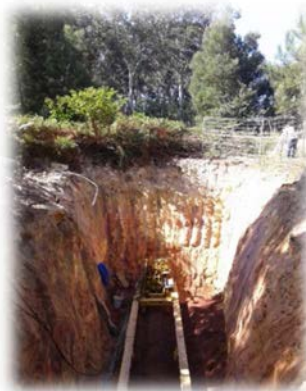
Perfuração horizontal no caminho de ferro
