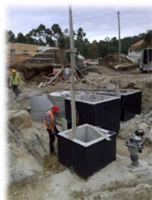
Acabamentos na Estação Elevatória
