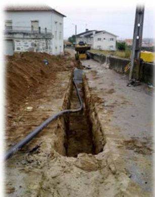
Instalação da conduta de elevatória de saneamento
