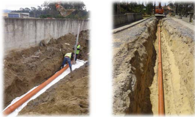
Instalação do coletor de águas residuais
