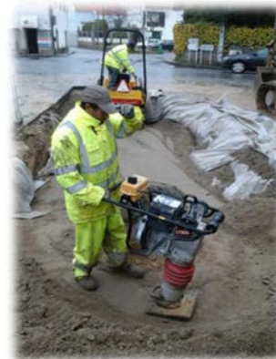
Compactação da vala, reparação do coletor
