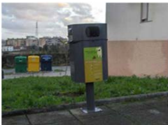
Colocação de equipamentos
