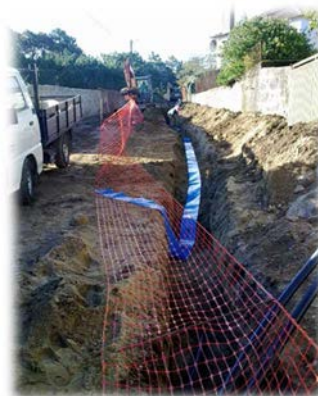
Rede de água no Caminho S. João Ester, Chafé
