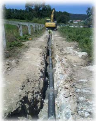
Instalação de coletor
