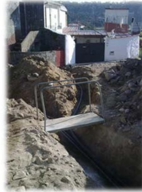
Instalação da conduta de elevatória residuais
