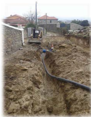
Instalação conduta de água
