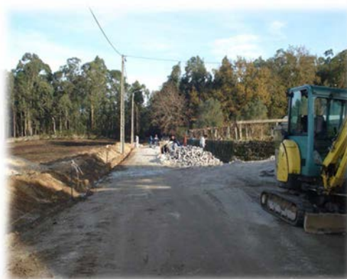
Trabalhos de pavimentação em cubo
