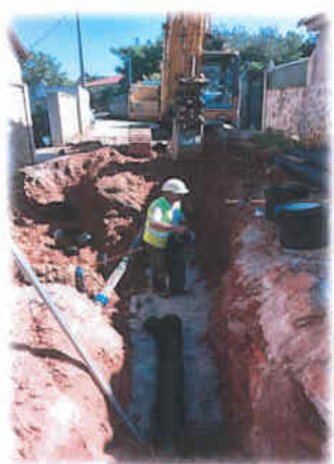
Figura n.º 4 e n.º 5 – Rede de saneamento – caixa de inspeção e coletor
