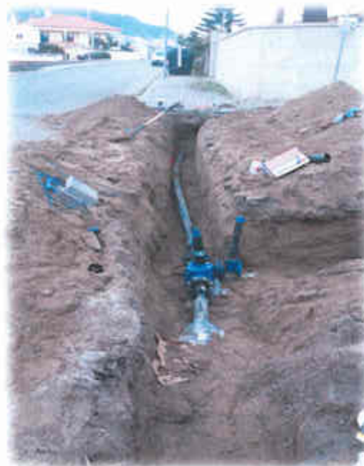
Figura n.º 8 e n.º 9 – Instalação de rede de água e execução de nó de ligação
