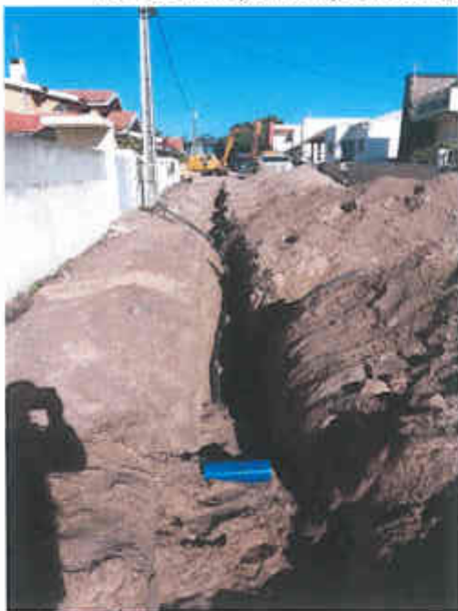
Figura n.º 8 e n.º 9 – Instalação de rede de água e execução de nó de ligação
