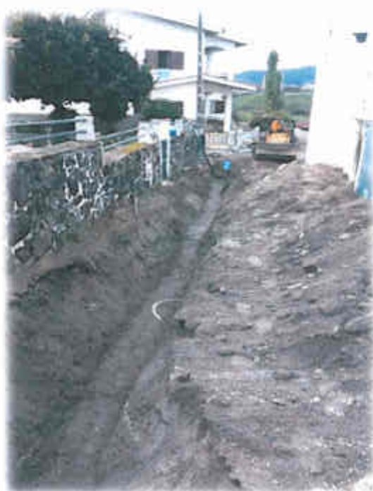
Figura n.º 14 – Instalação da rede de água
