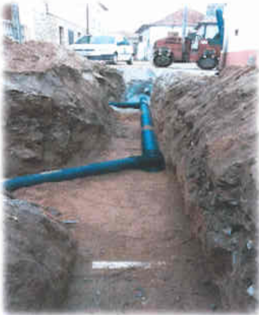
Figura n.º 10 – Instalação de coletor de saneamento
