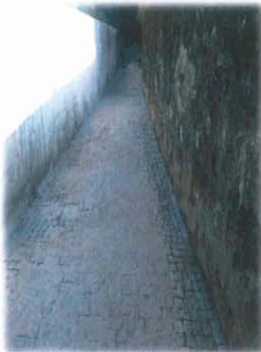
Figura n.º 15 – Trabalhos de pavimentação em cubo
