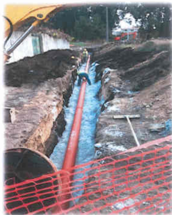
Figura n.º 16 e n.º 17 – Rede residual – instalação de caixa de ramal e coletor
