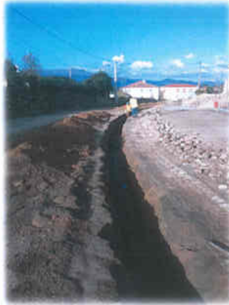
Figura n.º 11 – Instalação de conduta de água
