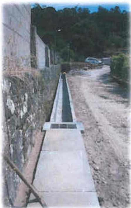
Figura n.º 6 – Box-Couvert de águas pluviais Figura n.º 7 – Instalação de coletor de saneamento
