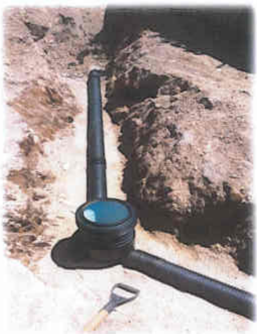
Figura n.º 4 e n.º 5 – Rede de saneamento – caixa de inspeção e coletor
