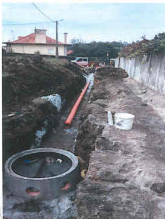
Figura n.º 16 e n.º 17 – Rede residual – instalação de caixa de ramal e coletor
