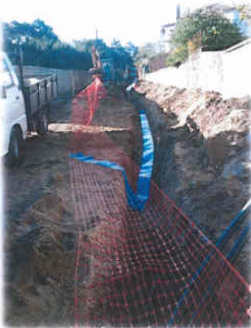
Figura n.º 12 – Instalação conduta de água
