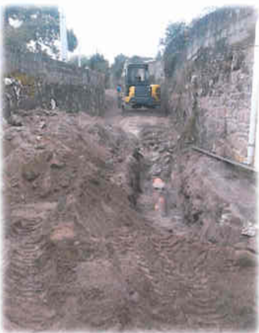
Figura n.º 3 – Instalação de coletor residual
